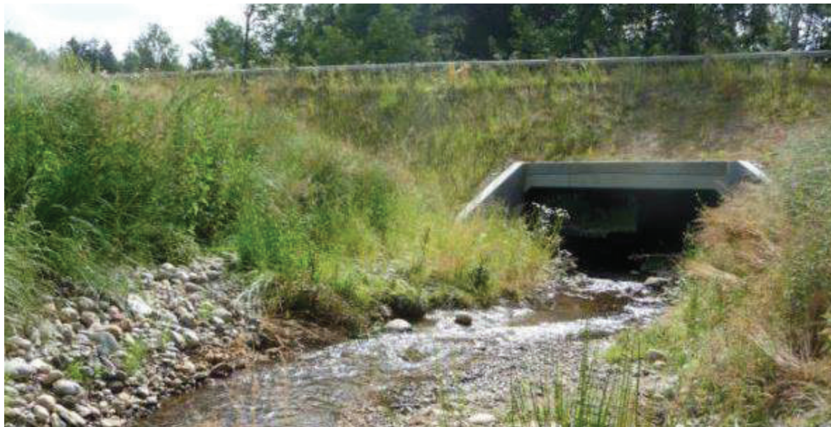
Figur 39 Eksempel på betonelementtunnel fra Perstrup
