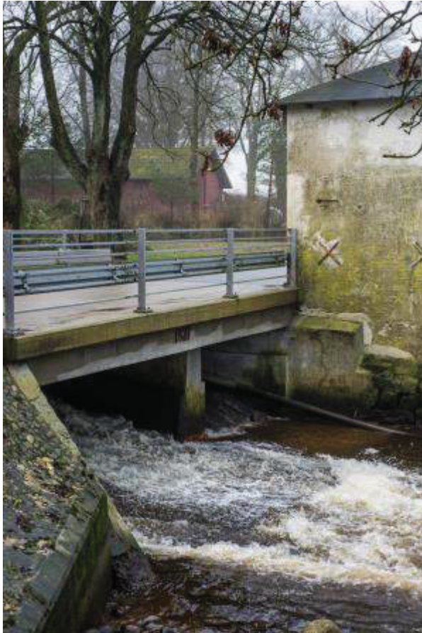
Figur 19 Møllebygningen nedstrøms stemmeværket set mod sydøst.
