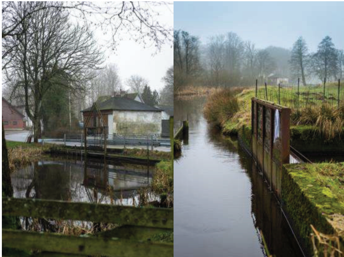
Figur 13 Stemmeværket ved Drivervej (til venstre) og det eksisterende vandindtag til dambruget i St. 9.715 m (til højre)
