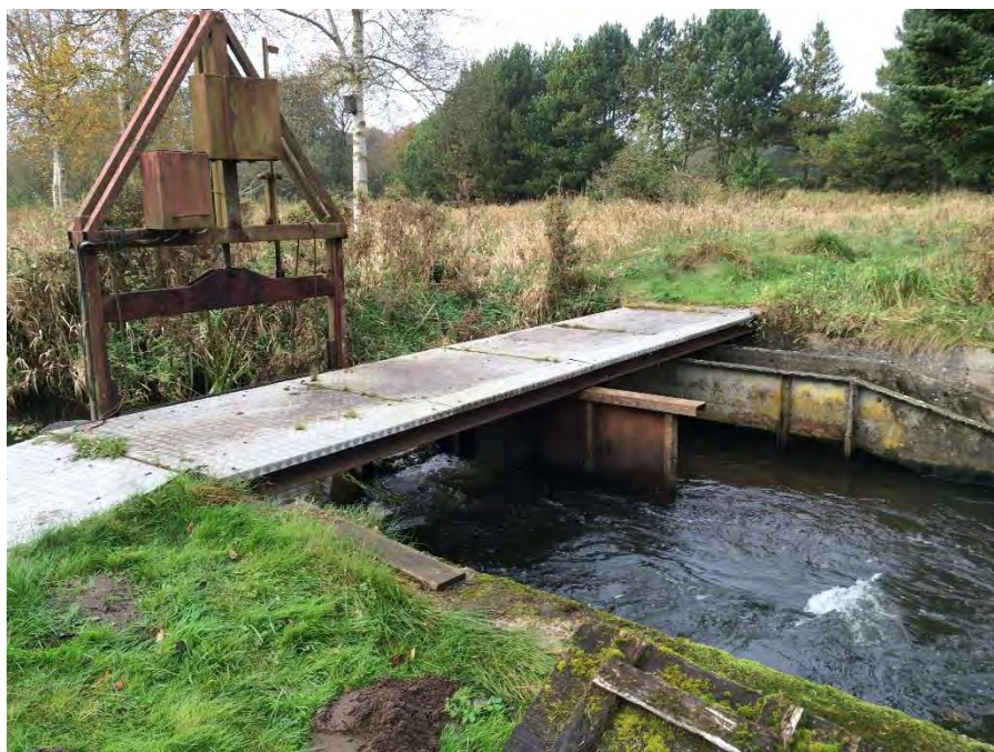
Figur 4. Resterne af opstemning ved Vejen Lille Vandmølle, RIB-00233. Der er tre passager for vandet igennem opstemningen, hvor den nederste i billedet er den mest vandførende.
