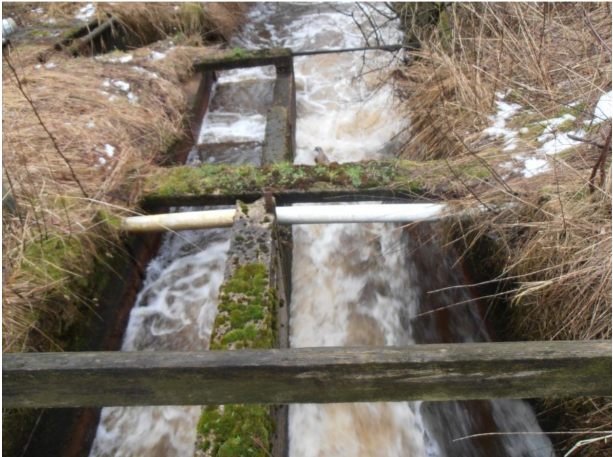
Foto 2 Bassintrappe og betonplade på nedstrøms side af stemmeværket
