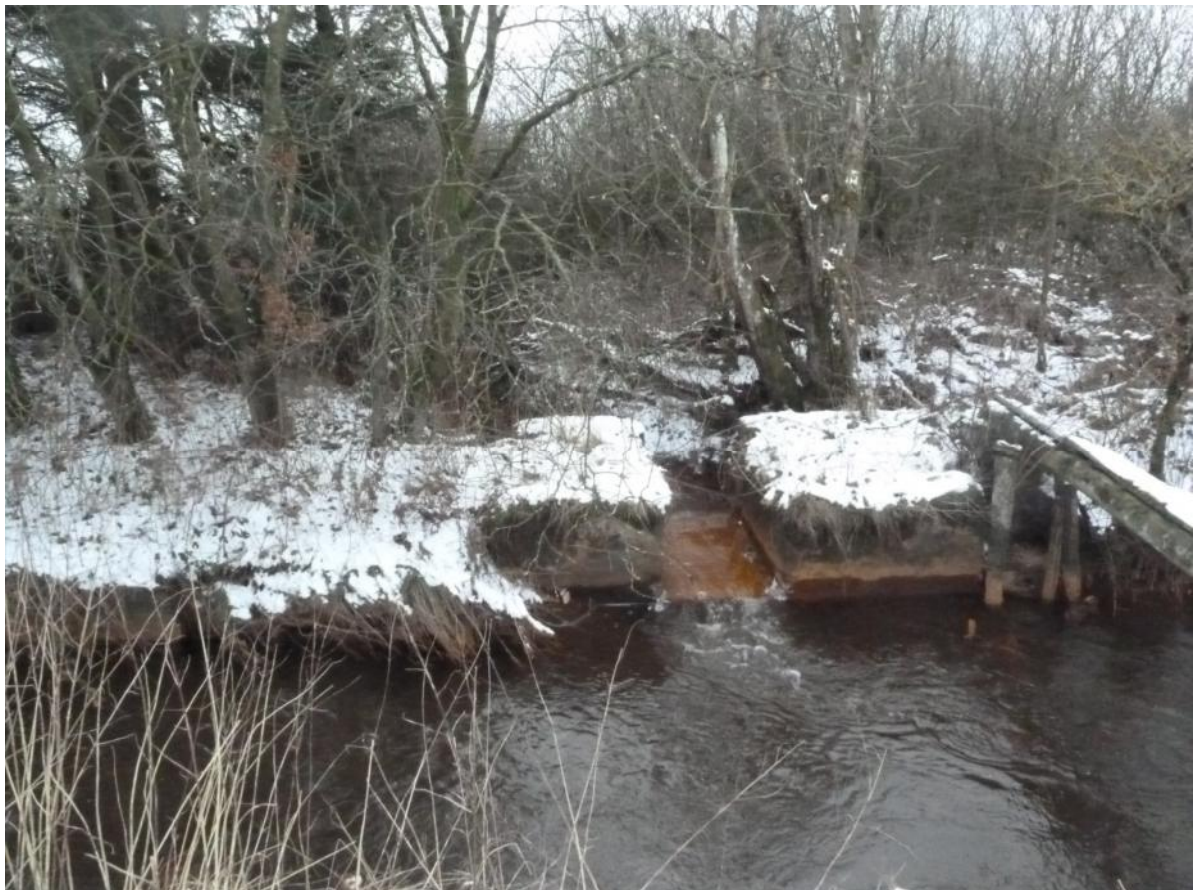
Foto 3 Tilløb fra syd med rester af betonstemmeværk (St. 6.873 m).
