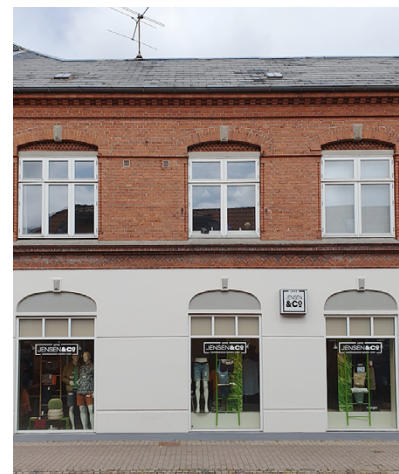
Figur 29. Med harmoni mellem vinduesformaterne fremstår bygningen som helhed fra terræn til tag.
