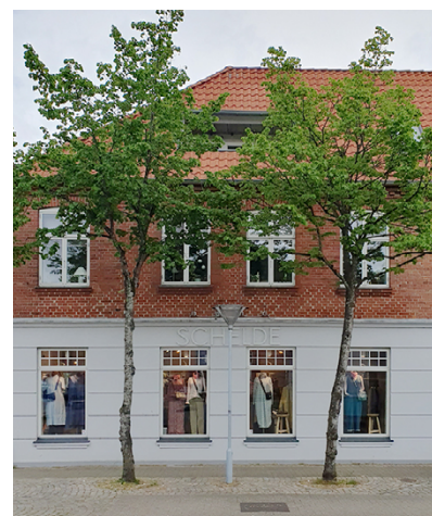
Figur 26. Eksempel på en facade med en stueetage i en afvigende farve, der passer til bygningens arkitektur.
