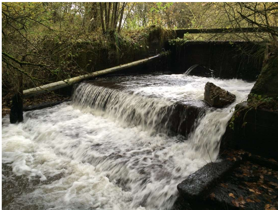
Figur 5. Indsats RIB-00239 i Holme Å ved Østerbygård Dambrug bestående af et opstemningsbygværk med en opstemningshøjde på 1,85 m.
