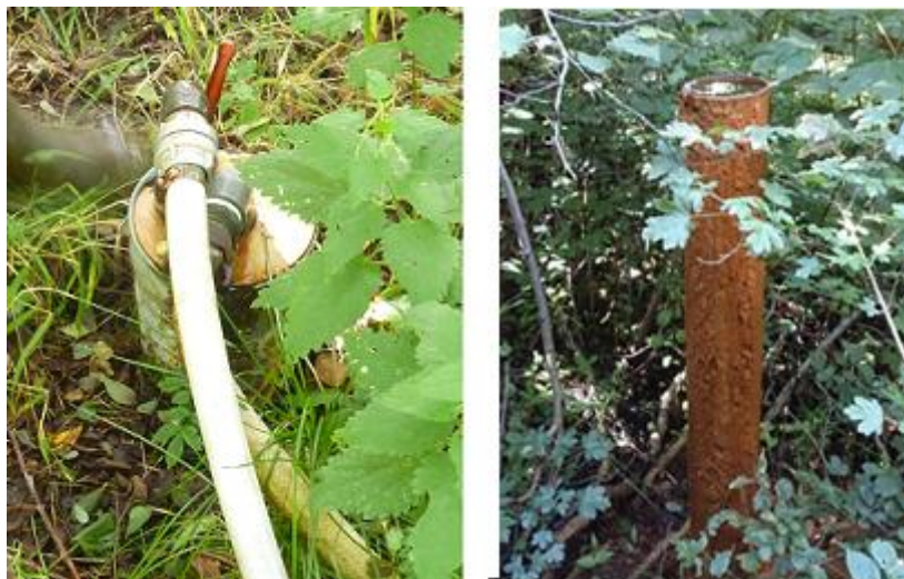
Figur 29 Eksisterende boring med artesisk vandspejl til højre. Til venstre boring DGU nr. 122.221
