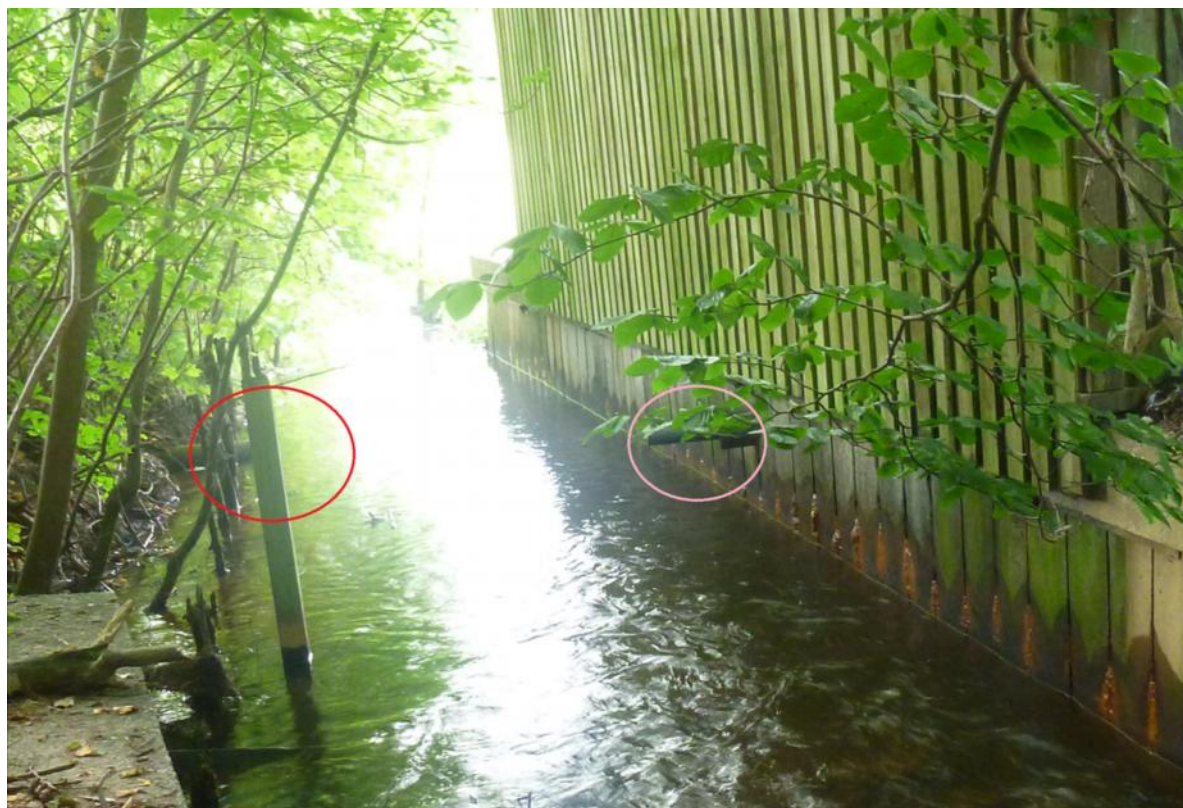
Figur 17 Ø 100 mm rørudløb fra klækkehus er angivet med pink. Ø 250 mm rørudløb fra syd er angivet med rød cirkel.
