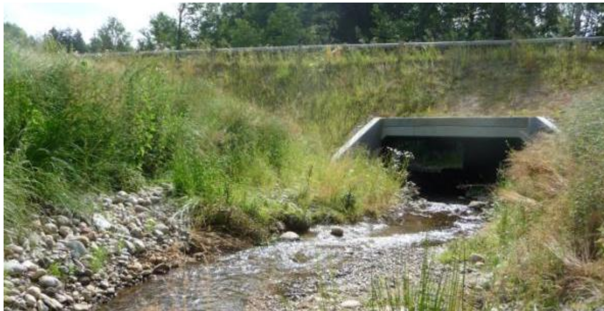
Figur 26 Betonelementtunnel fra Perstrup
