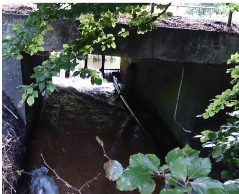
Figur 14 Eksisterende brogennemløb ved Tvilhovej set nedstrøms (vest) fra
