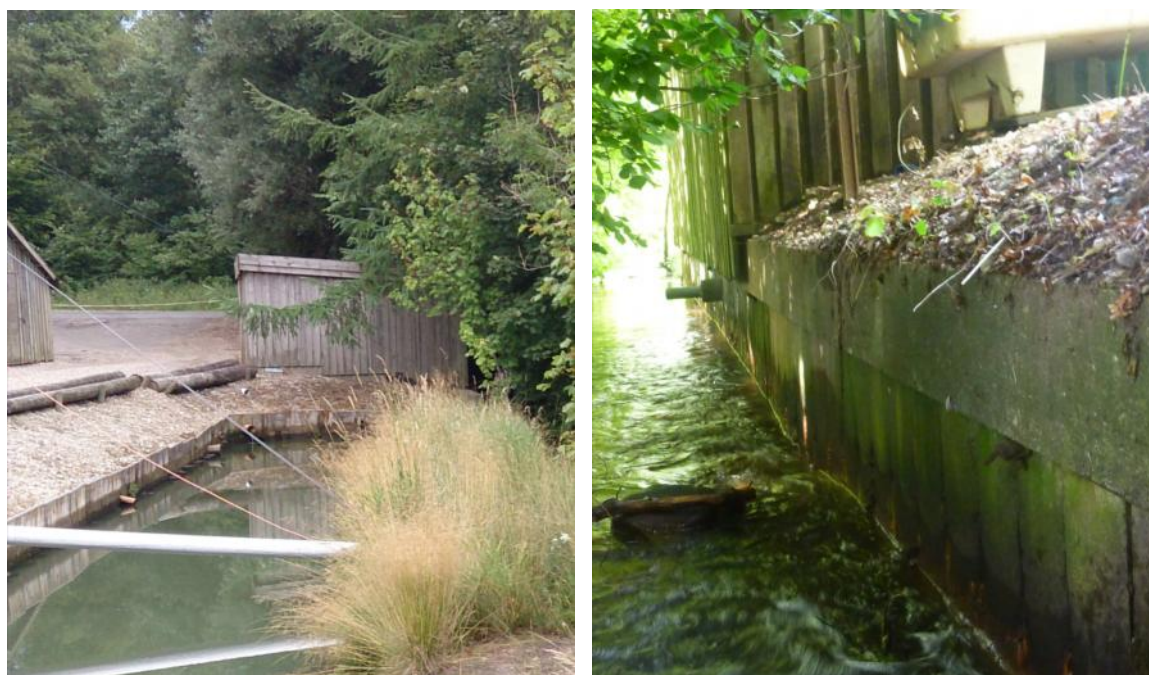
Figur 15 Tv. Klækkehuset og en af klaringsdammene ved Tvilho Dambrug. (fotograferet mod øst)
