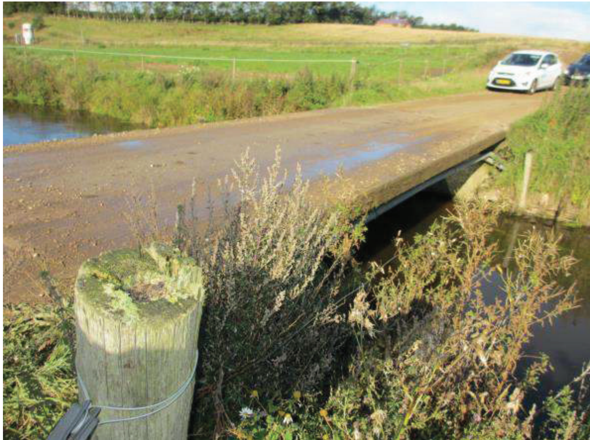
Figur 14 Eksisterende brogennemløb ved Gørklintvej set fra sydøst mod nordvest.
