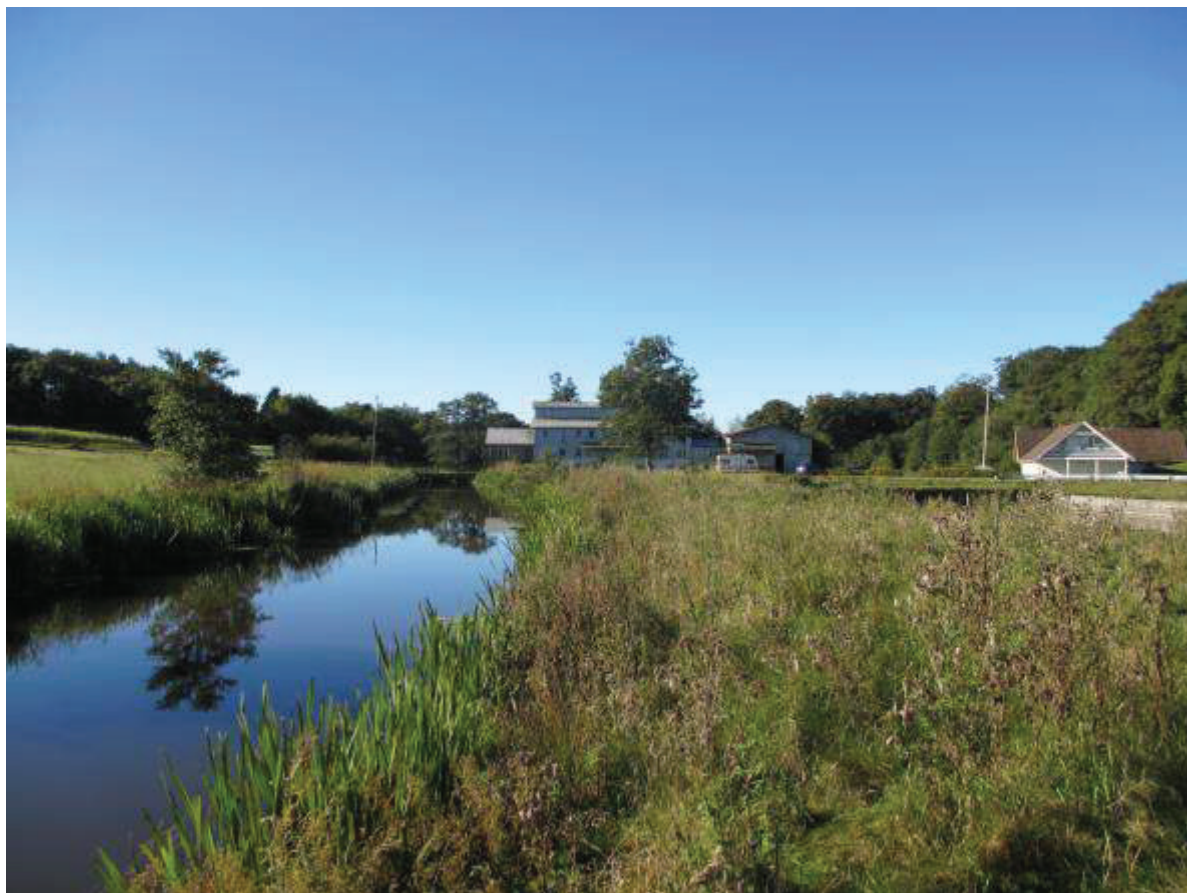
Figur 17 Ejendommen Møllevej 1 er placeret i højre side af fotoet (set fra øst mod vest). Det eksisterende forløb af Holsted Å er i venstre side af fotoet. Møllebygningen ses i midten.
