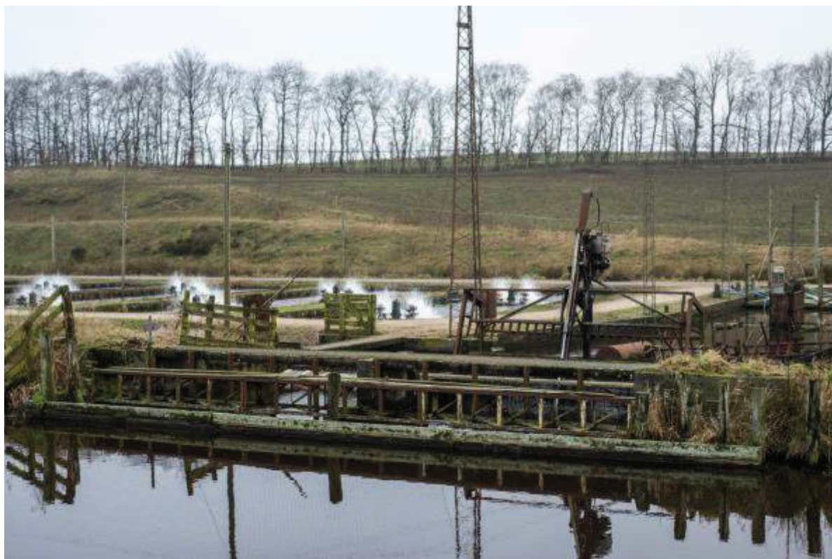
Figur 12 Indløbsbygværk ved Gørklint Mølle Dambrug i St. 16.678 m
