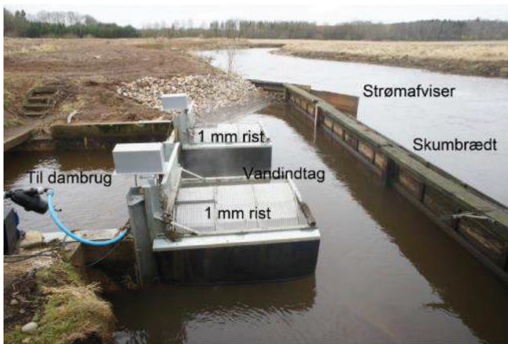
Figur 32 Indløbsbygværk ved Sig Fiskeri i Varde Å (foto: Jan Nielsen, DTU Aqua /10/).
