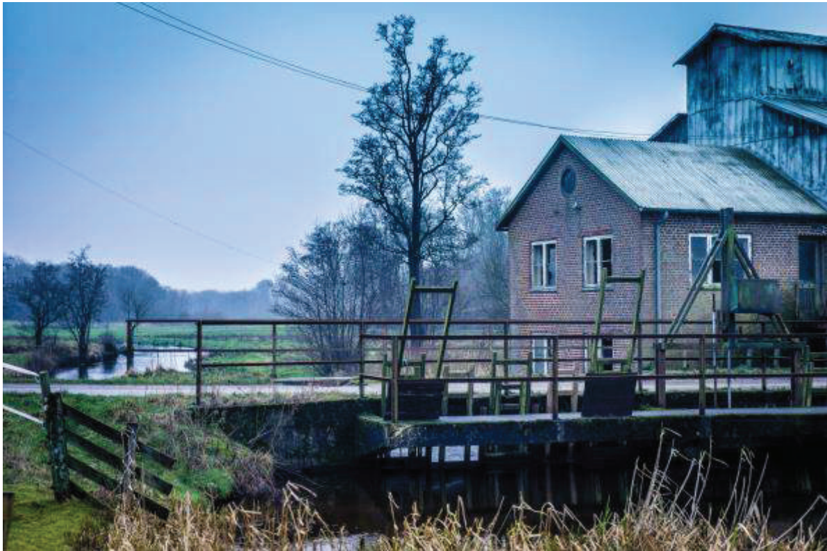
Figur 13 Stemmeværket ved Møllevej i St. 17.045 m.
